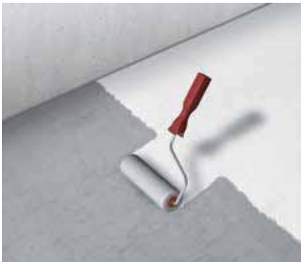
3 Application of the primer
