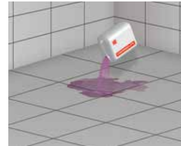
3 Pouring out ASO®-Unigrund-S
