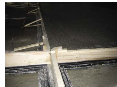
Príklad napojenia vonkajších tesniacich profilov pre pracovné a dilatačné škáry
