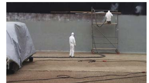
Aplikácia ochrany povrchu betónu GEPOTECH-11/22 v silážnej nádrži
