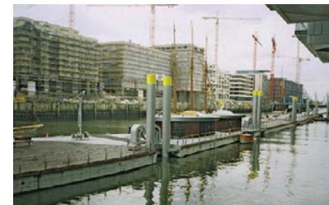
Plávajúce betónové pontóny s prísadou BETOCRETE C-17
