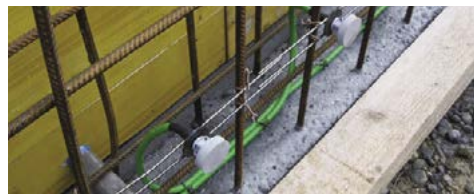
Injektážna hadička AQUAFIN-CJ2, osadená v strede styku základová doska – stena a ukončená injektážnymi obturátormi
