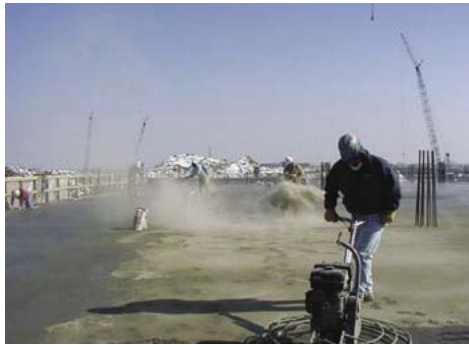
Aplikácia AQUAFINuIC vsypom do mladého betónu, s následným zapracovaním pomocou rotačných hladidičiek
