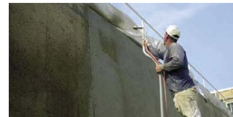
Plošná aplikácia AQUAFIN-u-1K pomocou striekacieho zariadenia
