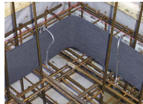
Osadenie AQUAFINu-CJ5 v styku „základová doska – stena“
