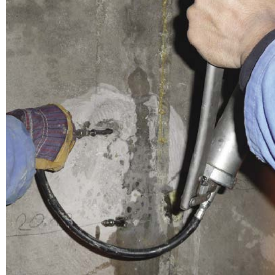
Injektáž trhliny AQUAFINom-P1 + P4
