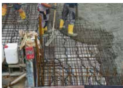
Základová doska po inštalácii výstuže
