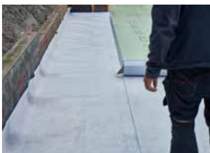
Spoje hydroizolačnej fólie
