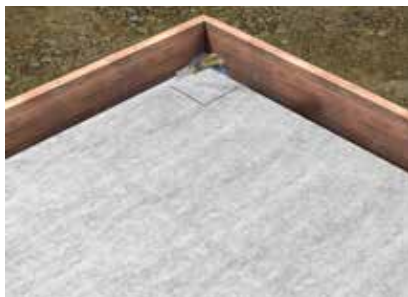
2a. Rozloženie fólie AQUAFIN-WM12 a vystrihnutie rohov podľa výšky debnenia.
