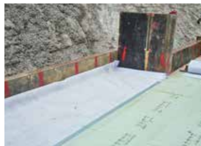
Podklad z tepelnoizolačných dosiek
