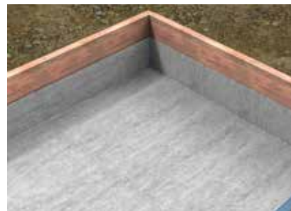
3a. Zatlačenie hydroizolačnej fólie do rohu, zahnutie hrán a zafixovanie fólie do určenej polohy.
