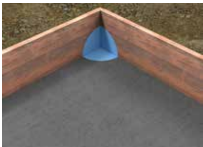
1a. Osadenie a zaistenie polohy vnútornej rohovej tvarovky k AQUAFINu-WM12.
