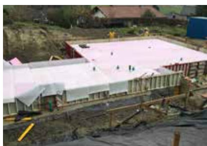
Plošná izolácia pred inštaláciou výstuže budúcej základovej dosky
