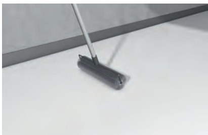
4. Обработка игольчатым валиком
