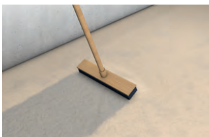
1. Очистка грунтовки, удаление не прилипшего к основанию кварцевого песка
