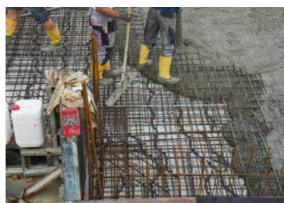
Напольная плита после укладки арматуры
