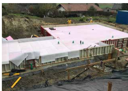
Уложенная плита основания перед укладкой арматуры
