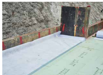
Основание под плитку при изоляции периметра
