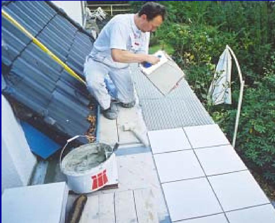
При укладке плитки избегать образования полостей
