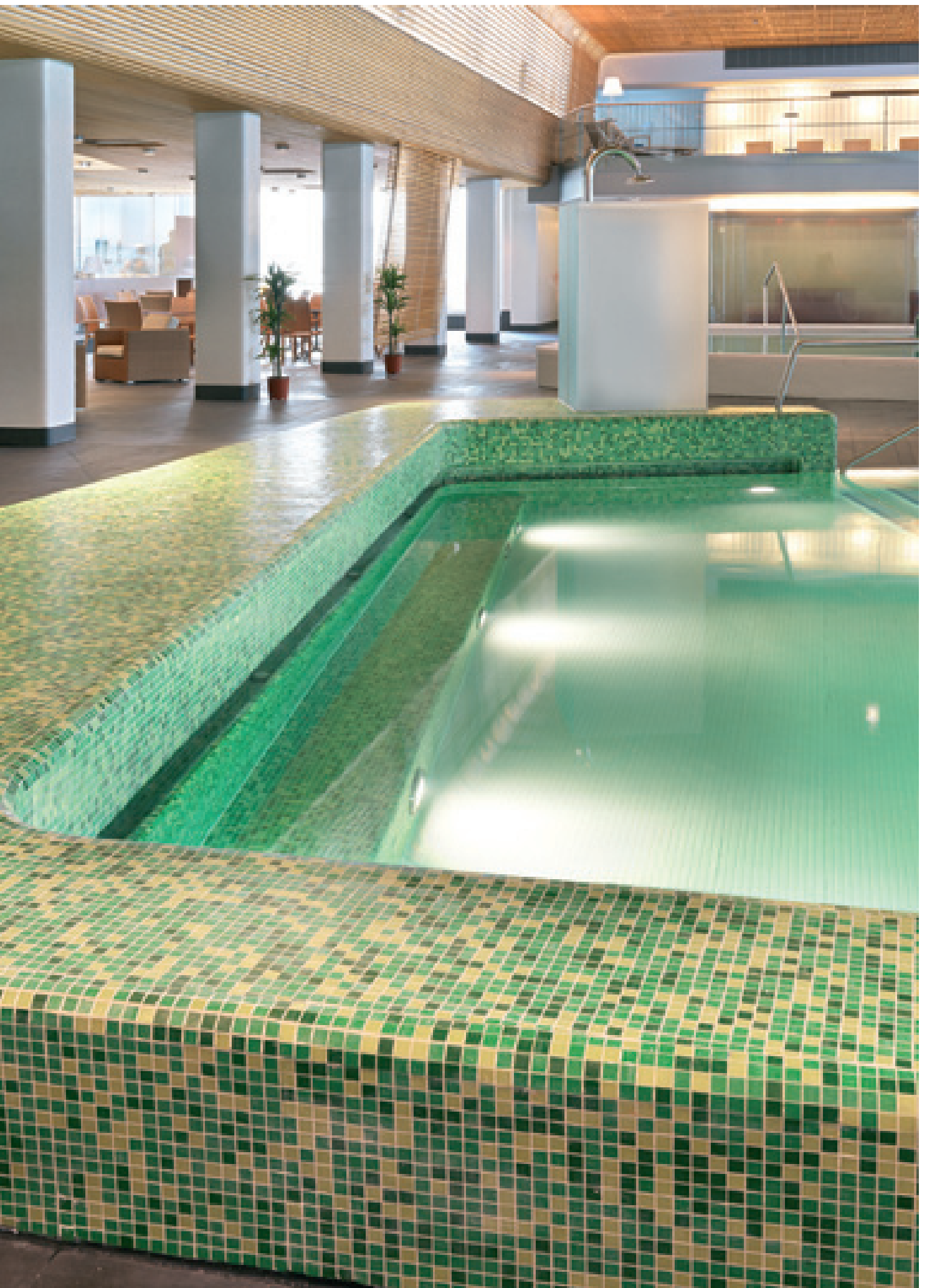
Глубокоустроенный Висбаденский желоб, Оздоровительный центр VitaSol в Bad-Salzuflen
