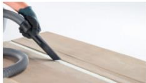
2. Oczyszczenie szczeliny
