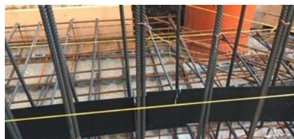
Blachy do przerw roboczych z powłoką krystaliczną - AQUAFIN-CJ5
