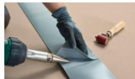
12. Zgrzewanie termiczne min. zakład 5 cm
