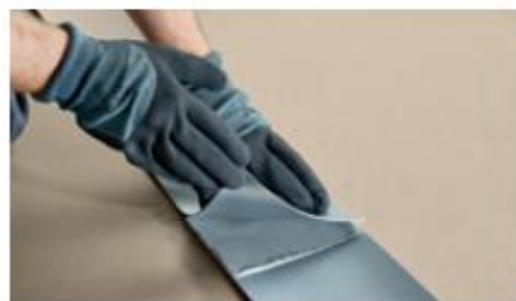
11. Łączenie taśmy klejem zakład ok. 5-10 cm Uwzględnić grubość taśmy 1 mm
