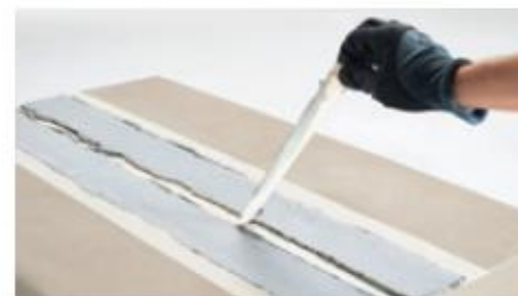
6. Oderwać taśmę ze szczeliny dylatacyjnej
