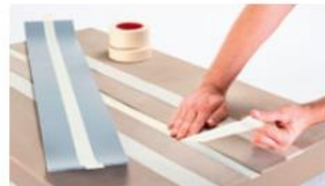
3. Przygotowanie podłoża (przykleić taśmę na szczelinie dylatacji)
