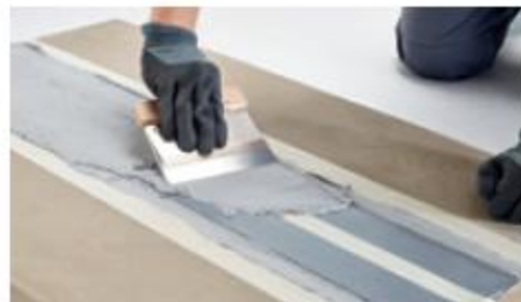
8. Nałożenie kleju ASODUR-K4031 na taśmę ASO-TAPE
