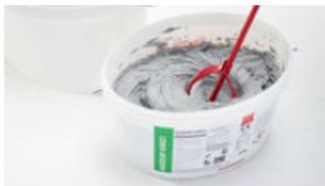
4. Przygotowanie kleju (wymieszać komponenty A i B)
