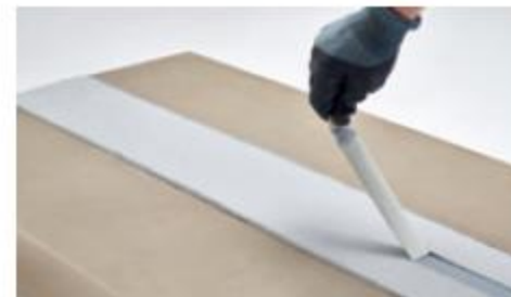
9. Oderwanie taśmy oznaczającą szczelinę
