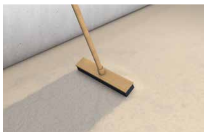
1. Grondering reinigen, los kwartzand verwijderen
