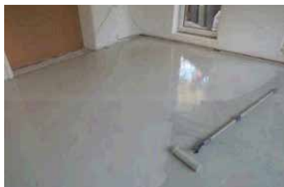
2. Aanbrengen van sealers
