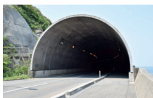
Tuneļi un betona caurules
