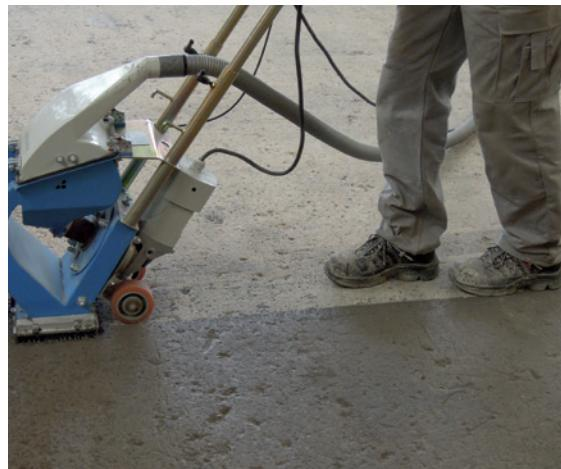
Для того, чтобы гидроизоляционный материал выполнял свою функцию надёжно на протяжении длительного времени, необходимо, чтобы он гармонировал с основой и был хорошо с ней связан.
