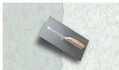
2. Нанесение saniрующей штукатурки
