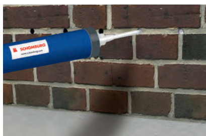
5. Ввести горизонтальную отсечную гидроизоляцию (кремообразную)
