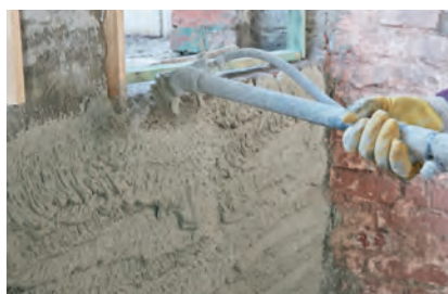
4. Нанесение основного слоя
