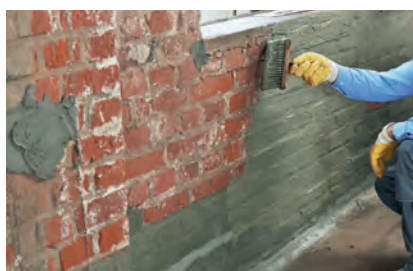
1. Подготовка места соединения пола и стены
