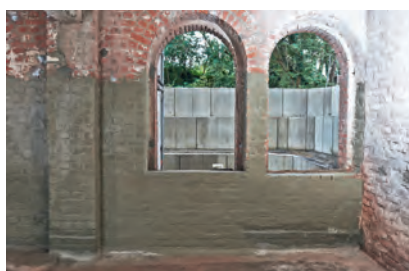
2. При необходимости: дополнительная гидроизоляция впереди основной
