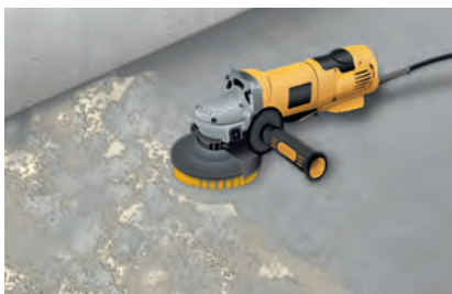
Абразивная обработка основания
