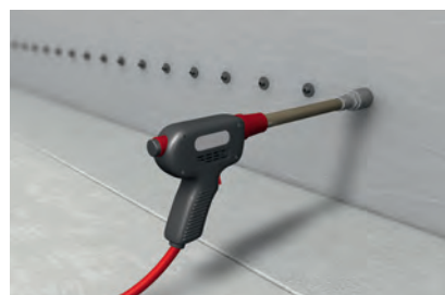
5. Ввести горизонтальную отсечную гидроизоляцию (жидкую)
