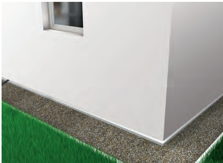
Горизонтальная отсечная гидроизоляция
