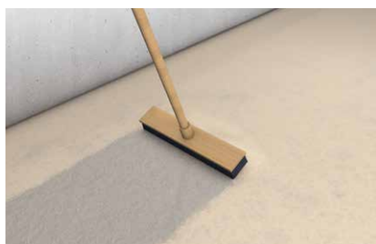
1. Nettoyer le primaire, éliminer le sable de quartz non adhérent
