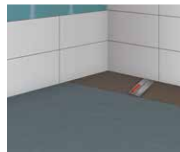
10 Application du mortier peigné
