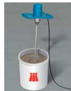
4 Malaxage du mortier colle
