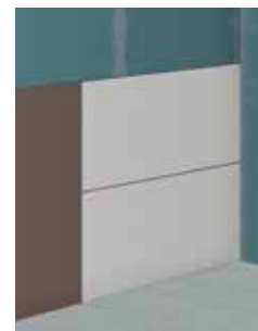
7 Pose de la céramique au mur
