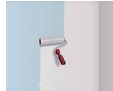
3 Application du primaire sur le support, p. ex. ASO®-Unigrund
