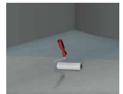
8 Application du primaire sur le support, p. ex. ASO®-Unigrund
