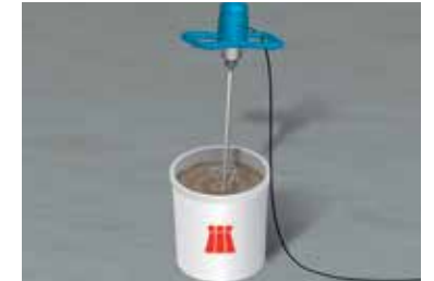
4 Préparation du mortier colle
