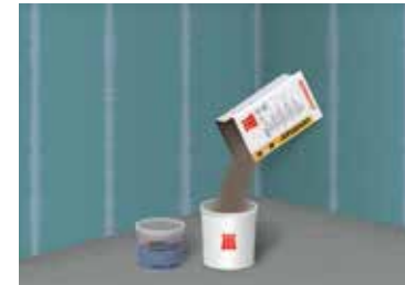
3 Le contenu du sac de mortier colle est versé dans un seau propre
