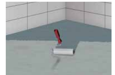
8 Application du primaire sur le support, p. ex. ASO®-Unigrund
