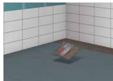
11 Application d'une couche de contact pour un revêtement grand format
