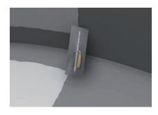
6. Etanchéité de surface Appliquer l'Etanchéité AQUAFIN-2K/M-PLUS à la brosse, à la lisseuse ou par projection, en un minimum de deux couches.
