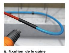
de décompression Amener sur la jonction des gaines d'injection et de décompression env. 6 - 8 cm de flexible rétractable à chaud. Chauffer à l'air chaud jusqu'à le voir se rétracter et se resserrer tout autour de l'assemblage.
