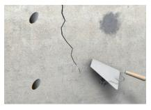
6. Obturation des forages Après durcissement de la résine d'injection, le colmatage peut, pour des raisons d'aspect, être retiré. Boucher les trous forés avec l'Enduit fin ASOCRET-BIS-1/6.
