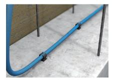
3. Positionnement de la gaine Poser la gaine d'injection en s'assurant d'une épaisseur de béton ≥ 8 cm du côté exposé à l'eau puis la fixer sur le béton avec des clips plastique (6 au mètre), afin d'éviter tout déplacement ou flottement.
