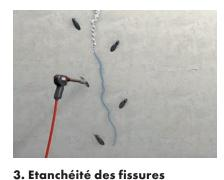
aquifères Mettre en place les injecteurs dans les trous forés. En présence de fissures aquifères, injecter d'abord AQUAFIN-P1. Le produit réagit avec l'eau en formant une mousse étanche à l'eau, élastique dure, et stoppe l'infiltration d'eau. La mousse expulsée sera éliminée après durcissement, de façon à affleurer la surface.
