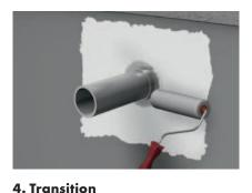
au niveau des brides Appliquer le Primaire spécial ASODUR-SG3-thix à la brosse ou au rouleau, sur la bride dépolie. Après durcissement, appliquer la 2ème couche de Primaire ASODUR-SG3-thix au rouleau puis saupoudrer le produit frais de sable de quartz de grain 0,5 - 1 mm.
