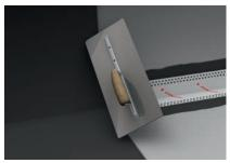
6. Etanchéité de surface Appliquer l'Etanchéité AQUAFIN-RB400 à la brosse, à la lisseuse ou par projection, en un minimum de deux couches.
