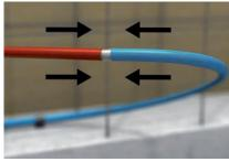
injectable Emboîter immédiatement le flexible AQUAFIN-CJ1 sur l'embout préparé, puis laisser sécher pendant la durée prescrite.
