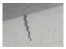
1. Réparation des fissures Evaluation et colmatage professionnels des fissures (voir le chapitre "Réparation des fissures").
