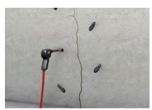
5. Etanchéité durable des fissures Si la Résine AQUAFIN-P1 est utilisée, l'injection complémentaire de Résine élastique AQUAFIN-P4 est nécessaire.
