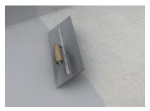
3. Egalisation de la surface Appliquer l'Enduit fin ASOCRET-BIS-1/6 sur le support préparé, en l'épaisseur souhaitée, (jusqu'à 6 mm en une passe). Post-traitement à la taloche éponge ou
