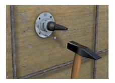
1. Injecteur standard Au niveau du premier et du dernier point (écart maximal 10 m) sur l'intérieur du coffrage, clouer un injecteur standard.
