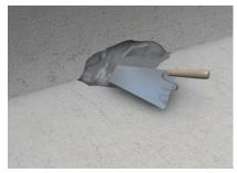
2. Egalisation des éclats Fermer les défauts et éclats à la truelle, avec le Mortier de réparation ASOCRET-BIS-5/40. L'application intervient "frais sur frais" sur le Badigeon d'accrochage ASOCRET-KS/HB.
