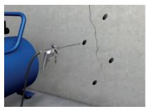
2. Nettoyage Vider les trous forés de leur poussière avec un compresseur (air comprimé sans
