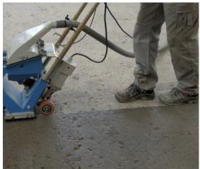
Les produits d'étanchéité doivent être compatibles avec le support et doivent présenter une adhérence optimale pour assurer durablement leur fonction. Pour cette raison, la préparation du support – avec ses exigences spécifiques – est réglementée dans les parties 1 et 3 de la norme all. DIN 18533, qui définit les principes et les points de détails, entre autres la planéité, l'élimination des bavures et le nettoyage, auxquels l'applicateur est contraint
