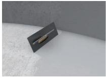
2. Egalisation de la surface Application en une passe du Mortier minéral ASOCRET-BIS-1/6 sur le support préparé, en l'épaisseur souhaitée (≤ 6 mm). La surface ne doit pas être retouchée, ni à la lisseuse, ni avec une brosse humide. Pour une réparation sans trace de reprise, il est possible de talocher ensuite la zone avec une éponge.
