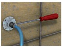
2. Fixation du flexible d'injection Fixer soigneusement la gaine AQUAFIN-CJ1 à l'injecteur à l'aide du collier de serrage.
