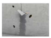
4. Colmatage des fissures En présence d'une fissure non aquifère, utiliser la Résine ASODUR-EKF pour la colmater. L'injection de la Résine AQUAFIN-P4 intervient après durcissement complet du colmatage.
