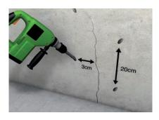
1. Forage des trous Selon un angle de 45° par rapport à la fissure, opérer des forages tous les 20 cm, décalés de part et d'autre de la fissure.
