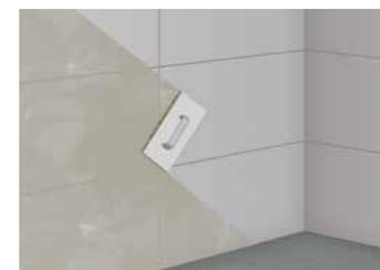
9 Nettoyage de la surface, en diagonale par rapport aux joints
