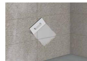
6 Retrait de l'excédent de mortier en un mouvement diagonal
