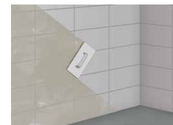
Remarque: Cette méthode d'application est également valable pour les murs.
