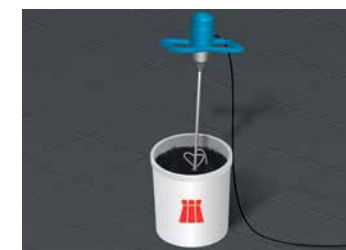
4 Malaxage du mortier de joint
