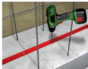
Alternative: fixation mécanique
