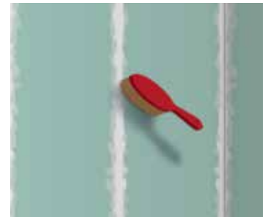
1 Nettoyage du mur
