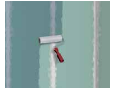
2 Application du primaire au mur
