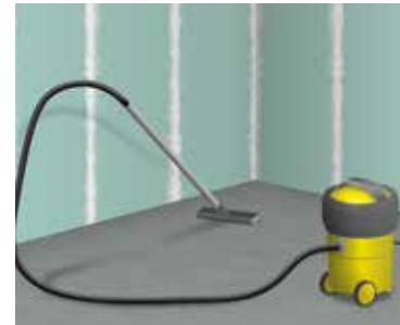
3 Nettoyage du support sol
