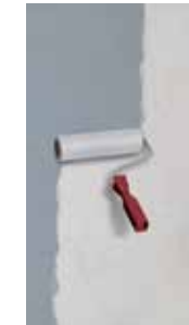
3 Primaïrisation du support, p. ex. avec ASO®-Unigrund
