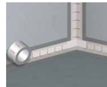
5 Collage de la Bande d'étanchéité ASO®-Dichtband-2000-S dans la 1 ère couche d'étanchéité
