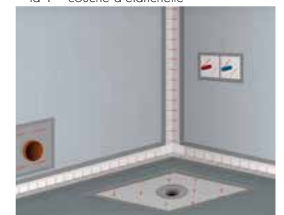
8 Eléments d'étanchéité ASO® mis en place
