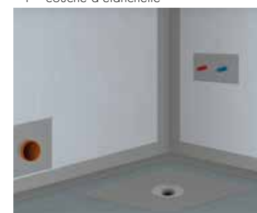
9 ...et recouverts avec l'étanchéité SCHOMBURG adaptée
