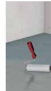
3 Primaïrisation du support, p. ex. avec ASO®-Unigrund
