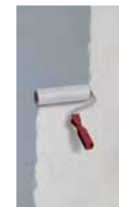
3 Primairisation du support, p. ex. avec ASO®-Unigrund
