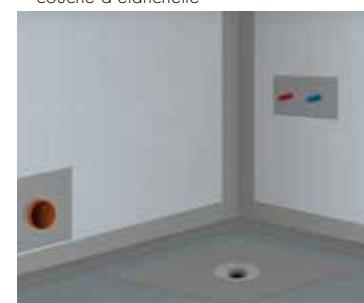
9 ... et recouverts de l'étanchéité SCHOMBURG adaptée
