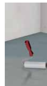
3 Primairisation du support, p. ex. avec ASO®-Unigrund
