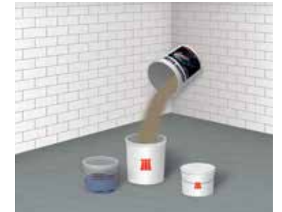
4 Préparation de l'étanchéité en respectant le dosage prescrit
