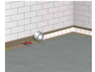
6 Collage de la Bande d'étanchéité de la gamme ASO-Dichtband dans la 1ère couche d'étanchéité
