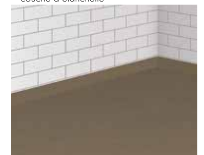
8 Laisser sécher la 1 ère couche d'étanchéité
