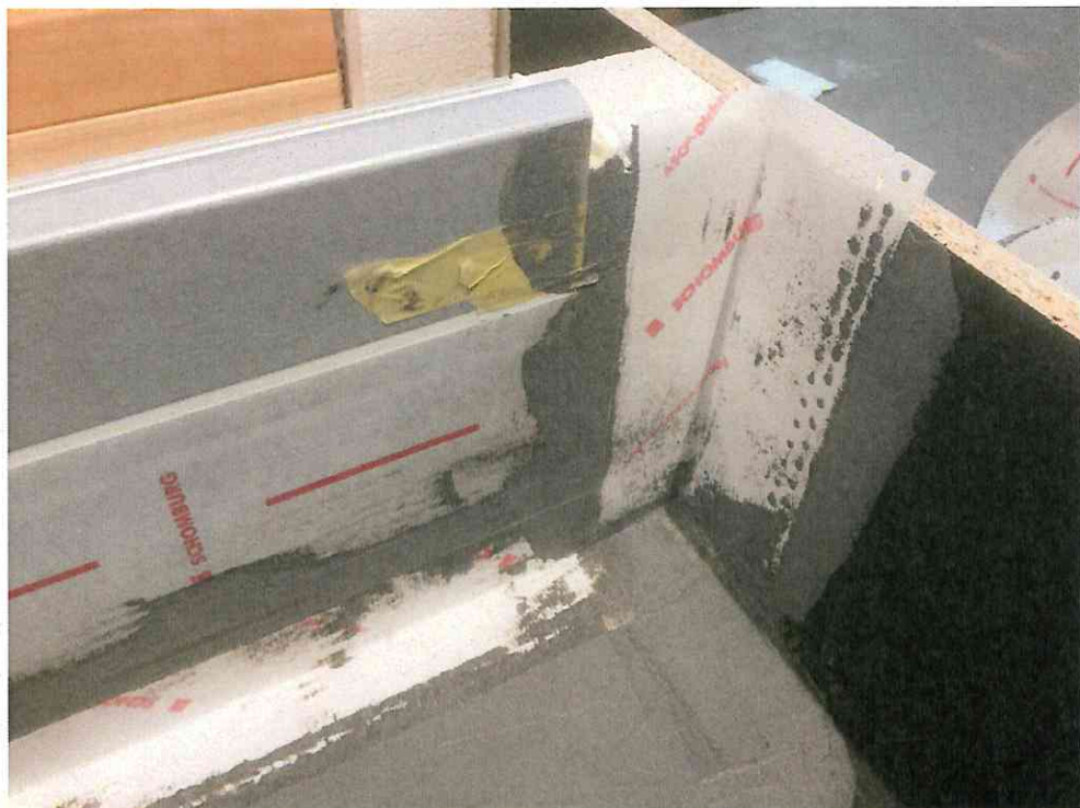
Bild A8: ASO-Dichtband-2000-S im Wand-/Wandbereich eingearbeitet
