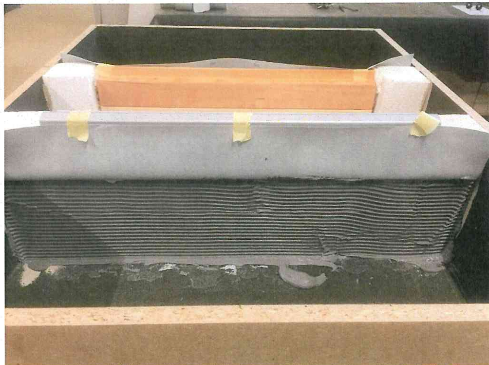
Bild A4: ASO-Anschlussdichtband hochgeklappt und AQUAFIN-RB400 vorgelegt
