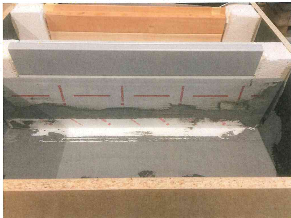
Bild A6: ASO-Dichtband-2000-S im Boden-/Wandbereich eingearbeitet
