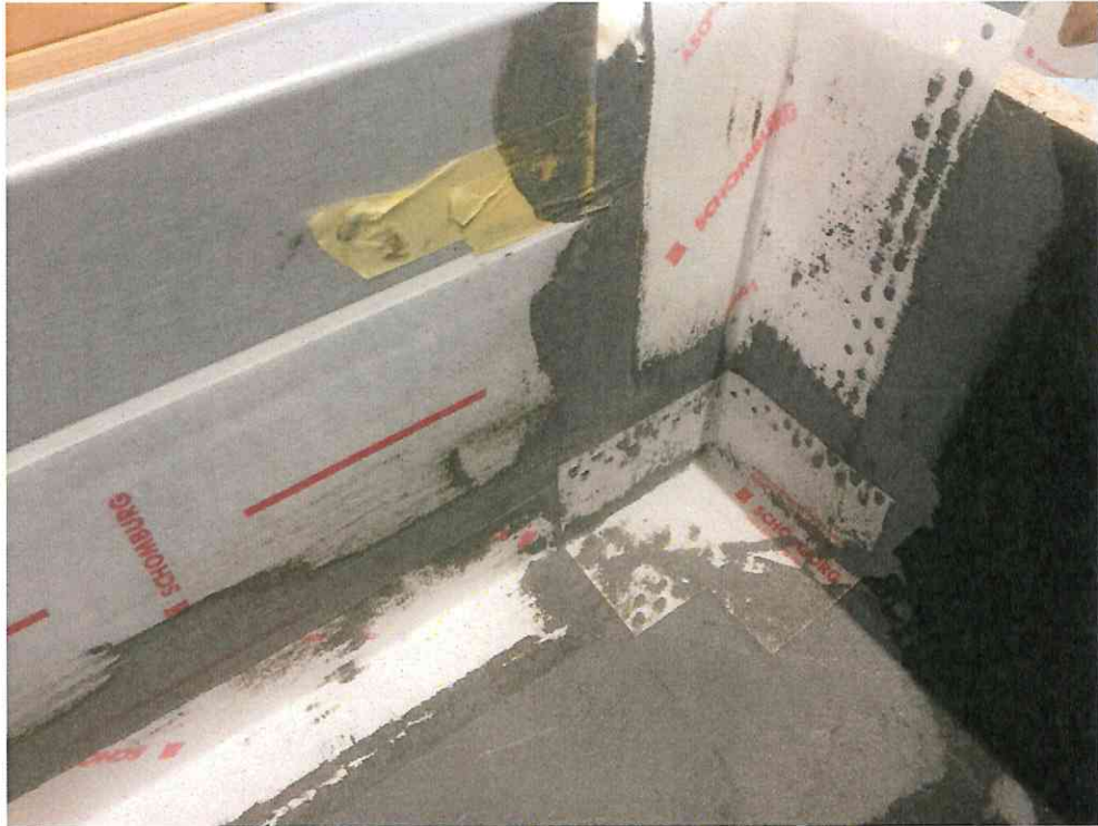
Bild A9: ASO-Dichtband-2000-S Innenecke eingeklebt
