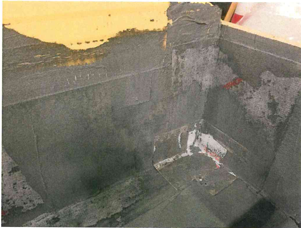
Bild A5: Einbau ADF-Dehnfugenband und ASO-Dichtband-2000-S-ecke im Eckbereich
