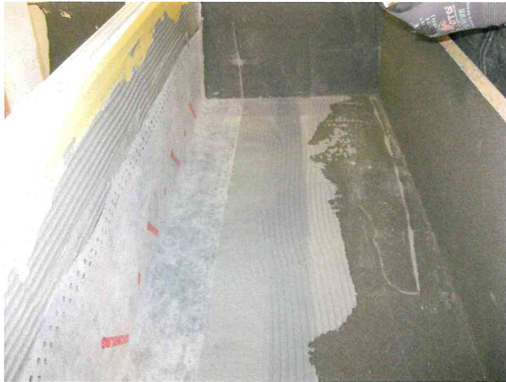
Bild A3: ADF-Dehnfugenband eingearbeitet
