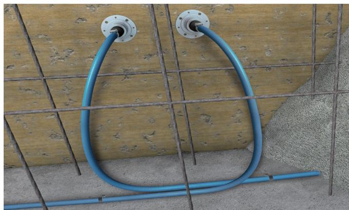
Durch die einfache Befestigungsart lassen sich auch schwierige Fugenverläufe anpassen. Bei Kontakt mit Wasser reagiert das enthaltene thermoplastische Elastomer und führt zu einer Volumengrößierung. Durch den resultierenden Anpressdruck dichtet das Material anschließend die Arbeitsfuge gegen die umliegenden Betonflanken ab.
