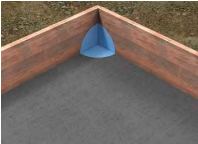
1a. AQUAFIN-WM12-Innenecke in die Ecke bringen und sichern.
