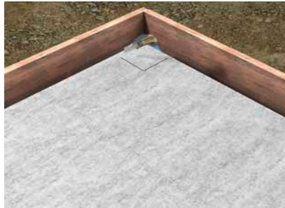
2a. AQUAFIN-WM12-Flächenbahn einzeichnen und in Höhe der Schalung ausschneiden.
