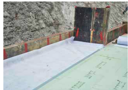
Verlegeuntergrund Perimeterdämmung
