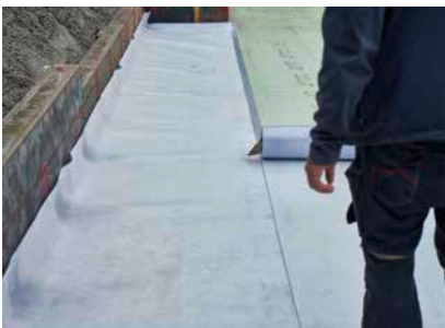
Überlappungsbereich Frischbetonverbundfolie
