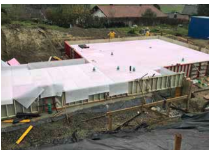
Verlegte Bodenplatte vor dem Einbringen der Bewehrung
