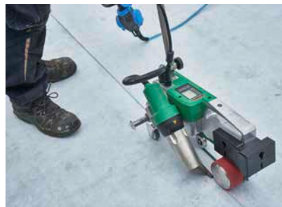
Fügemöglichkeit mit Maschinenschweißgerät
