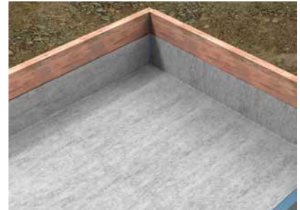
3a. Flächenbahn in die Ecke drücken, Seiten anwinkeln und Aufkantung fixieren.
