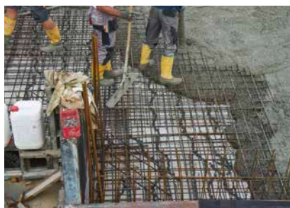
Bodenplatte nach Einbringen der Bewehrung
