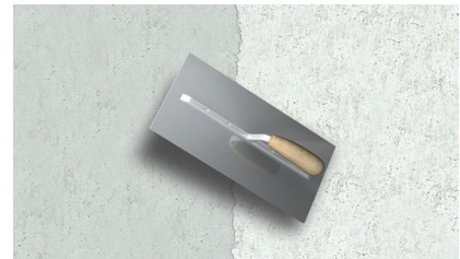
2. Sanierputz auftragen
