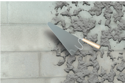
Spritzbewurf/Haftbrücke
