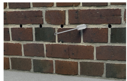
3. Bohrlöcher reinigen
