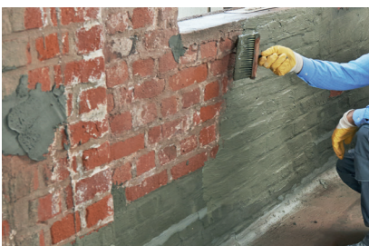
1. Vorbereitung des Boden-/Wandanschlusses
