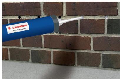
5. Horizontalsperre herstellen (pastös)
