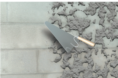
Spritzbewurf/Haftbrücke
