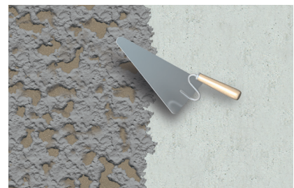
1. Evt. Grundputz auftragen
