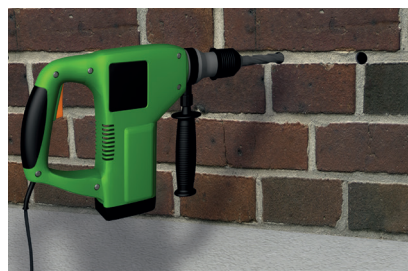
2. Bohrlöcher erstellen
