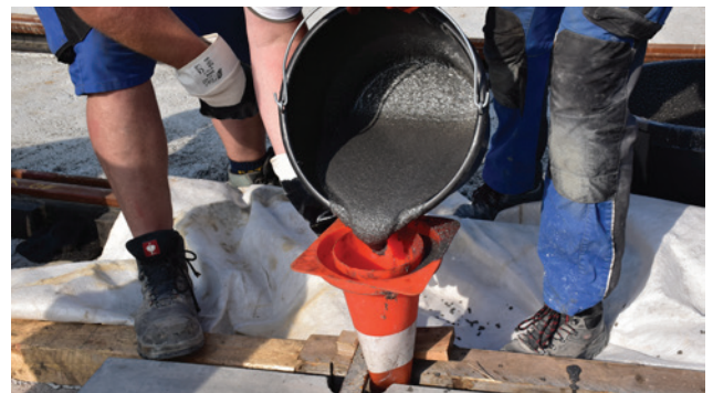
Praxisbeispiel Untergießen von Betonelementen
