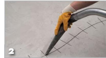
**2** Entfernen Sie Unreinheiten und säubern Sie den eingeschnittenen Bereich sorgfältig mit einem Industriestaubsauger oder Ähnlichem.
