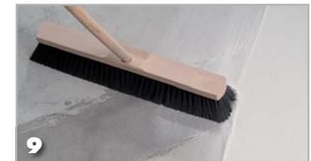
**9** Entfernen Sie nach dem Erhärten losen Sand durch Abfegen.
