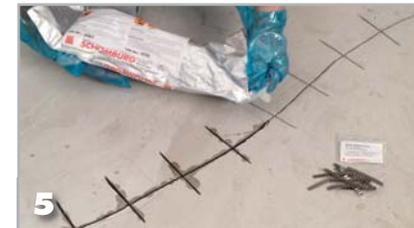
**5** Gießen Sie das angemischte Material in die vorbereiteten Schlitzte ein und füllen Sie diese ca. bis zur Hälfte. Verwenden Sie bei Bedarf den mitgelieferten PE-Schlauch zur Verlängerung.
