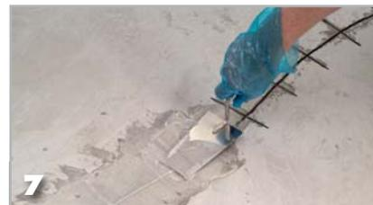
**7** Verschließen Sie mit einer spachtelbaren Masse aus ASODUR®-K900 und Quarzsand die Rissoberflächen.
