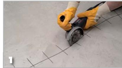
**1** Öffnen Sie den Riss oder die Fuge mit einer Trennscheibe der Länge nach – bis ca. zur Hälfte oder zu einem Drittel der Estrichtiefe. Schneiden Sie rechtwinklig zum Riss im Abstand von 30 cm 10 cm lange Querschlitzte ein.
