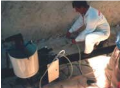
Die zu den Anlagen passende Injektionslanze gibt es je nach Mauerwerksstärke in verschiedenen Längen.
