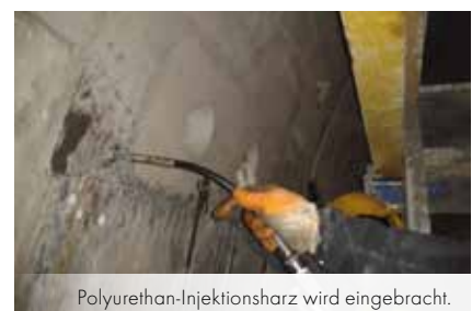
Undichte Verbindungsfuge.
