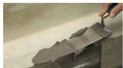
ASOCRET-M30 als Reparaturmörtel.
