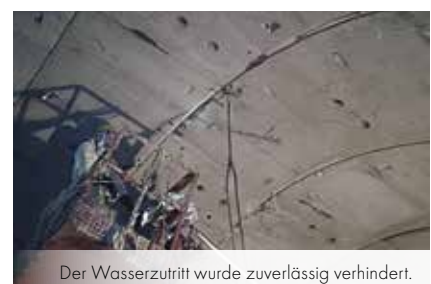
Polyurethan-Injektionsharz wird eingebracht.
