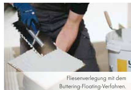
Aufkämmen des Fliesenklebers.
