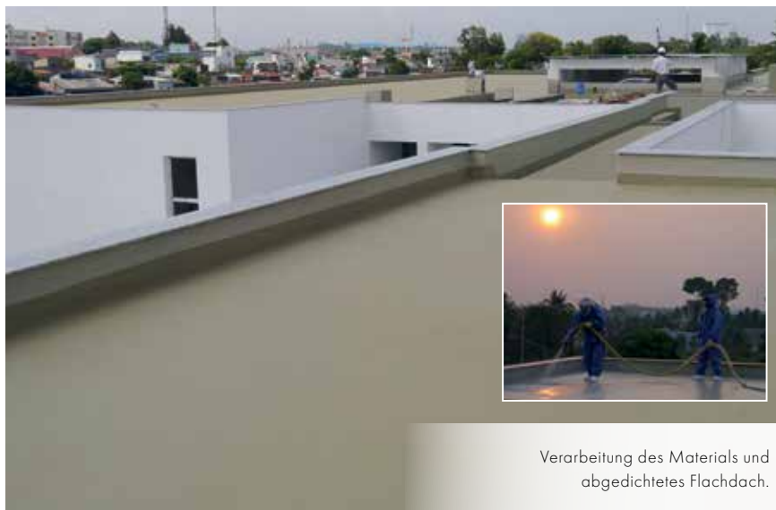
GEPOTECH®-Verarbeitungsvorführung auf einem Flachdach in Vietnam.
