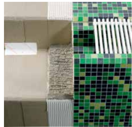
Abdichtungsaufbau mit AQUAFIN®-RS300 bei einer Wiesbadener Rinne.
