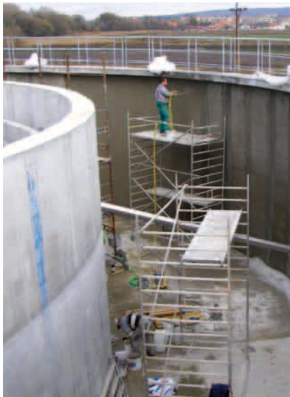
Flächenabdichtung - maschinelle Verarbeitung der kristallinen Dichtungsschlämme
