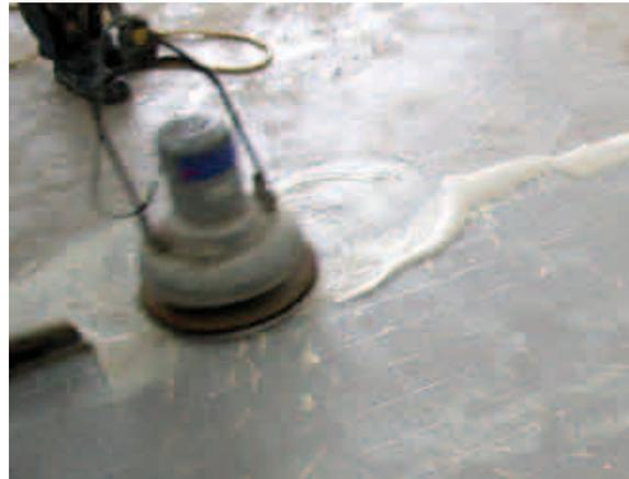
Maschinelles Einfügen des Fugenmörtels
