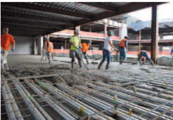
Aufbringen der Betondecke auf die Schwalbenschwanzunterkonstruktion
