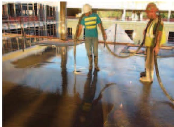
Schon 12 Stunden nach Einbau des INDUFLOOR®-IB1250 wurde die Fläche mit einem SUPERCAP Verlaufsestrich ausnivelliert. Mit diesem System konnte innerhalb von nur einer Woche diese 2.200 m<sup>2</sup> große Fläche soweit fertig gestellt werden, dass der endgültige Bodenbelag eingebaut werden konnte.
