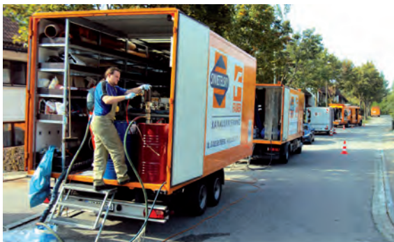
Die Sanierungsarbeiten an der Müllerstraße in Erding waren bereits nach zwei Wochen durch die Swietelsky-Faber GmbH abgeschlossen.
