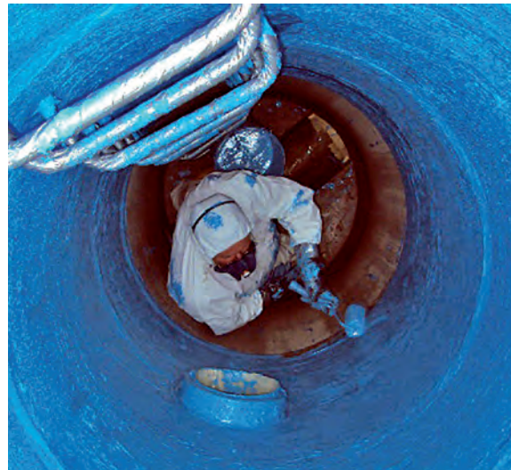
Nach der Hochdruck-Vorreinigung (oben) wird der blaue Primer als erste Phase des Systems GEPOTECH®-11/22 per Quast aufgetragen.
