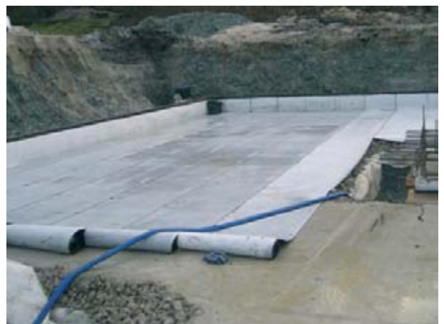
Die neue Kellerfolie ADF®-KE-F kam bereits bei mehreren Objekten, hier eines in Tallinn, Estland erfolgreich zum Einsatz.
