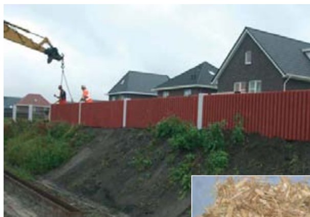
Bis jetzt wurden ca. 7.000 m 2 Lärmschutzwände hergestellt. Das kleine Bild zeigt aufbereitete Holzspäne, die bei der Fertigung zum Einsatz kamen.
