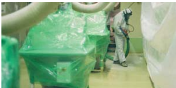
Applikation von GEPOTECH®-11/22 im Heißspritzverfahren.
