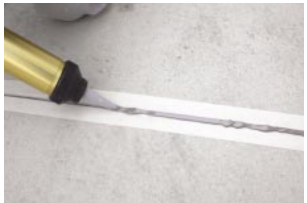
Verarbeitung von ASODUR®-LAU-TKF25 durch die Druck-Pistole
