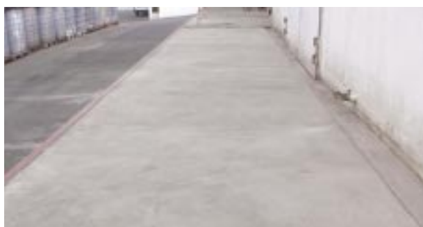
Mit ASOCRET®-RS beschichtete Rampe
