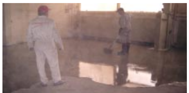
Auftragen der Spachtelmasse SOLOPLAN®-30 auf den Untergrund
