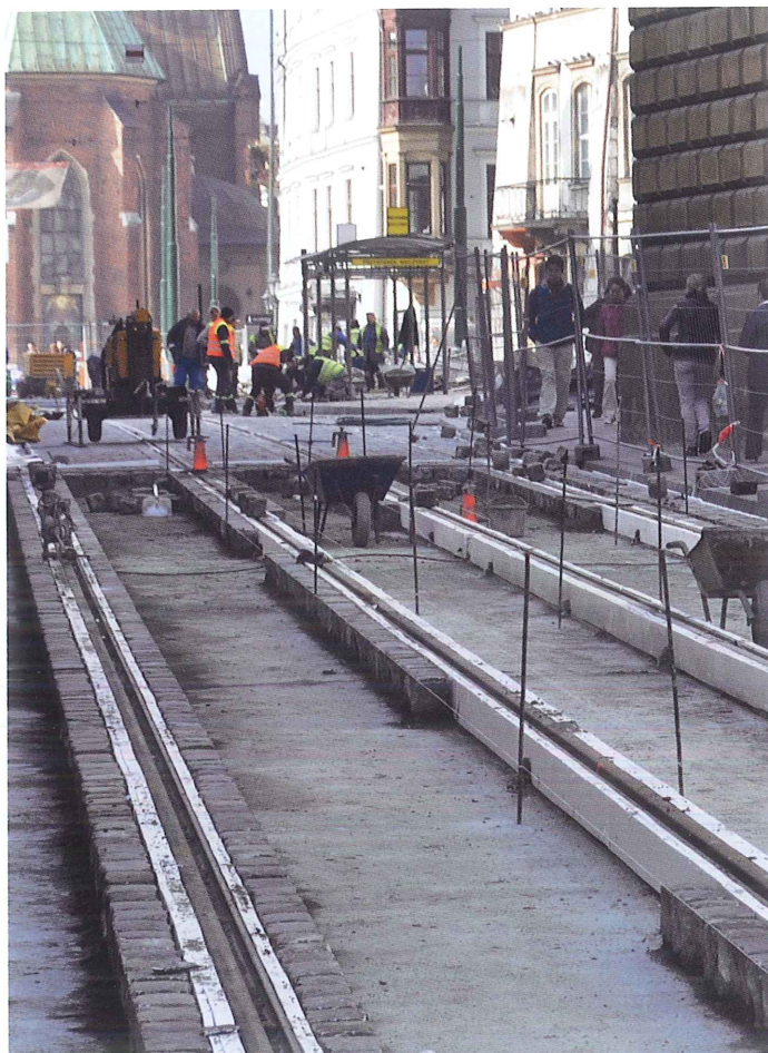
Links: Die Pflastersteine werden mit Bettungskleber auf dem Betonfundament fixiert und anschließend durch einen Fugenkleber miteinander verbunden. Rechts: Das Ergebnis ist eine äußerst belastbare Fahrbahn, die auch dauerhaft Bus- und Lkw-Rädern gewachsen ist.
