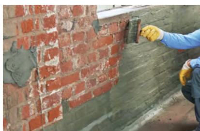
1. Příprava napojení stěna/podlaha
