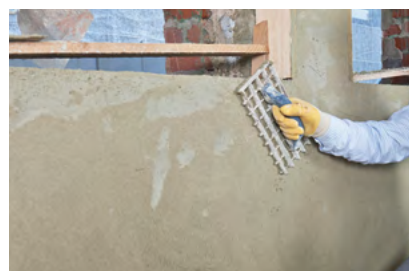
6. Opracování povrchu mřížkovým škrábákem
