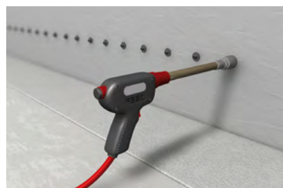
5. Vytvoření horizontální clony (pomocí injektážního roztoku)
