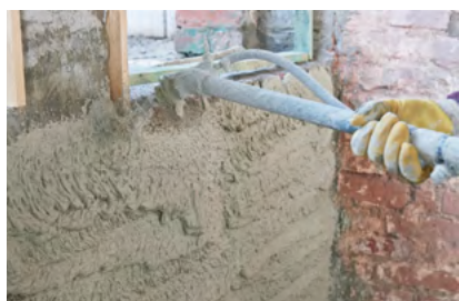
4. Aplikace vodonepropustné malty
