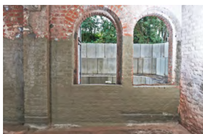
2. Hydroizolace (v případě potřeby)
