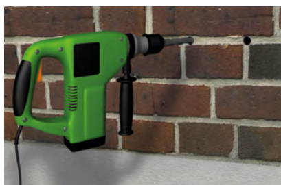
2. Vrtání injektážních otvorů
