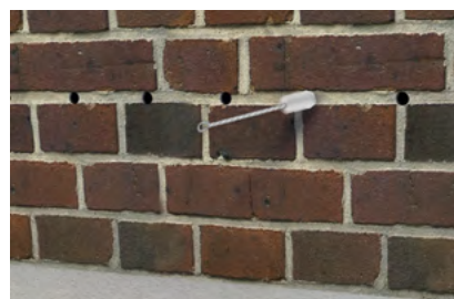
3. Vyčištění otvorů
