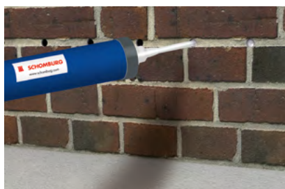
5. Vytvoření horizontální clony (pomocí injektážního krému)
