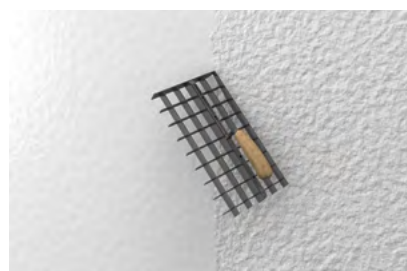
otevření povrchu mřížkovým škrabákem
