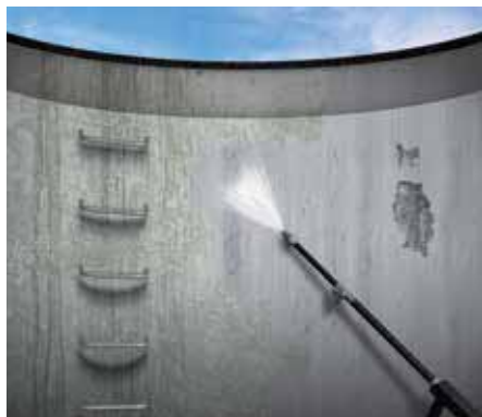
1 Očištění podkladu před aplikací
