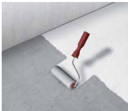
3 Nanesení penetrace
