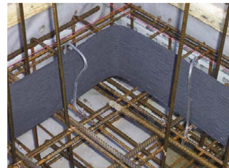
Osazení AQUAFINu-CJ5 ve styku „základová deska – stěna“
