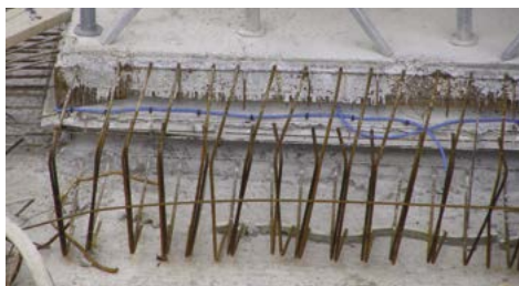
Těsnicí plech AQUAFIN-CJ5 a injektážní hadička AQUAFIN-CJ1, osazené ve styku základová deska – základová deska
