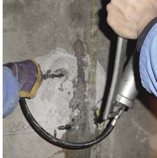
Injektáž trhlíny AQUAFINem-P1 + P4
