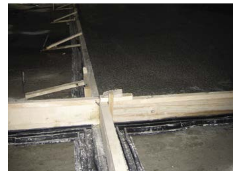
Příklad napojení vnějších těsnících profilů pro pracovní a dilatační spáry
