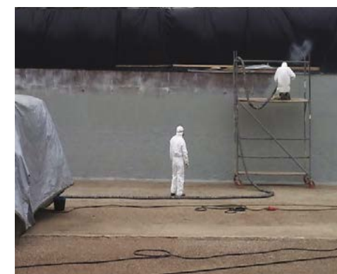
Aplikace ochrany povrchu betonu GEPOTECH-11/22 v silážní nádrži
