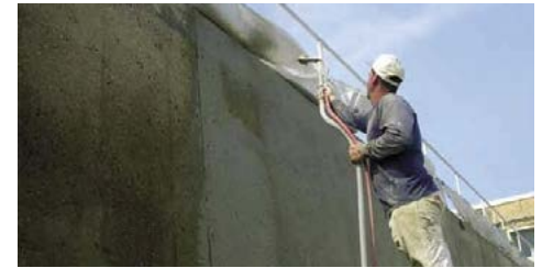
Plošná aplikace AQUAFINu-1K pomocí stříkacího zařízení
