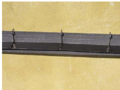
Ω-systém pro řízené trhliny
