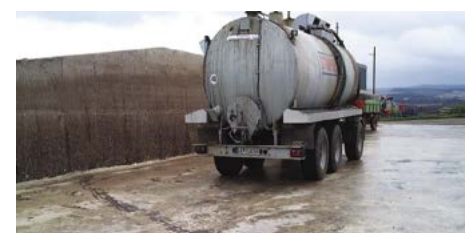
Koroze konstrukce silážní nádrže vlivem působení silážních šťáv
