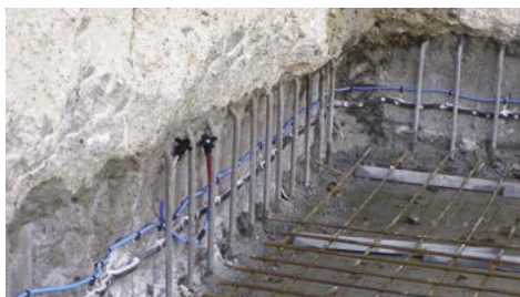
Bobtnavý pásek AQUAFIN-CJ3 a injektážní hadička AQUAFIN-CJ1, osazené ve styku základová deska – stěna
