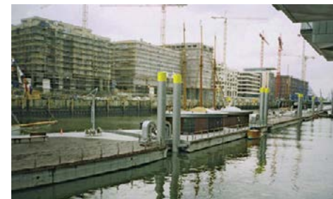
Plovoucí betonové pontony s přísadou BETOCRETE C-17
