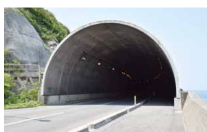
Tunely a betonová potrubí
