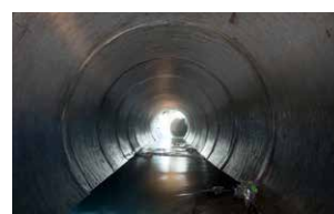
Kanalizace a šachty
