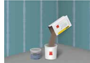
3 Einfüllen des Klebemörtels in ein sauberes Anmischgefäß
