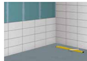
9 Einteilen der Bodenfläche
