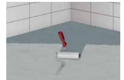
8 Grundieren des Untergrundes, z.B. mit ASO®-Unigrund
