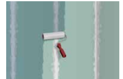
2 Grundieren des Untergrundes, z.B. mit ASO®-Unigrund
