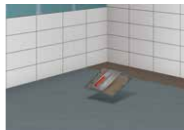
11 Auftragen einer Kontaktschicht bei größeren Formaten
