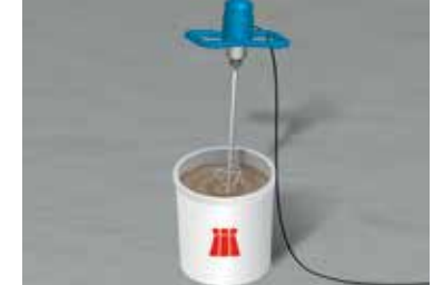
4 Anmischen des Klebemörtels
